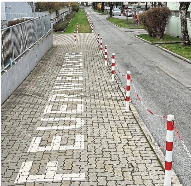
Gut geschützt ist die Zone vor parkenden Pkw und Lkw. So gut, dass auch Einsatzfahrzeuge kaum noch durchkommen
